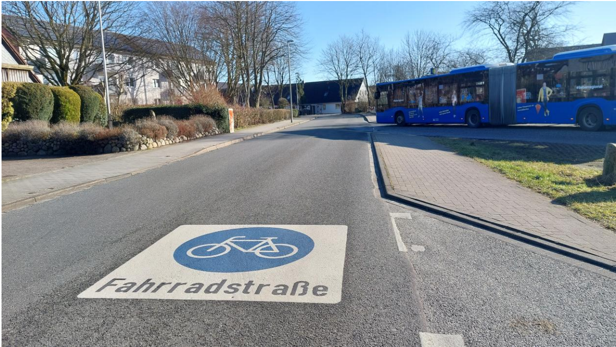
Großflächiges Piktogramm „Beginn einer Fahrradstraße“ in Flensburg (© Hannah Köster/ RAD.SH)
