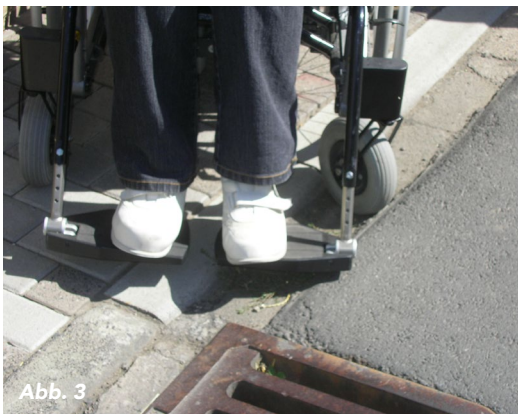
Abb. 3: An Engstellen müssen Borde oft überschritten werden, um die Fahrbahn mit zu benutzen. Zudem müssen sie dann oft noch schräg gequert werden. Deshalb ist eine weiche Separation (siehe Kap. 2.6 und RAS 5.2.5) in solchen Fällen die bessere Lösung.
