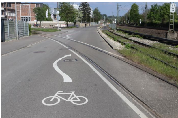
Markierungslösung, um Radfahrende zum Queren von Gleisen im besseren Winkel zu bewegen © Markus Belz
